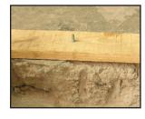
Colocar elemento a fijar, instale arandela y tuerca.
