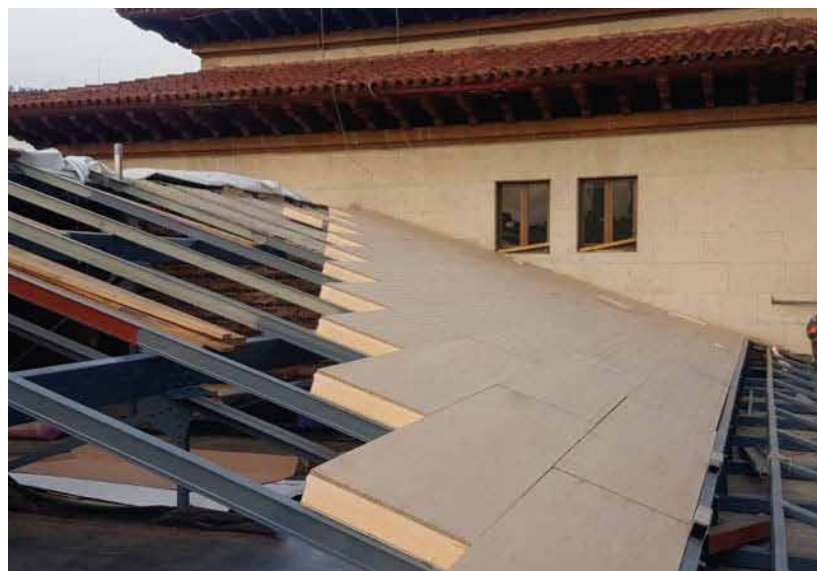
Fijación de paneles OSB a estructuras metálicas
