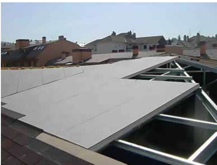
Fijación de paneles Internit a estructuras metálicas
